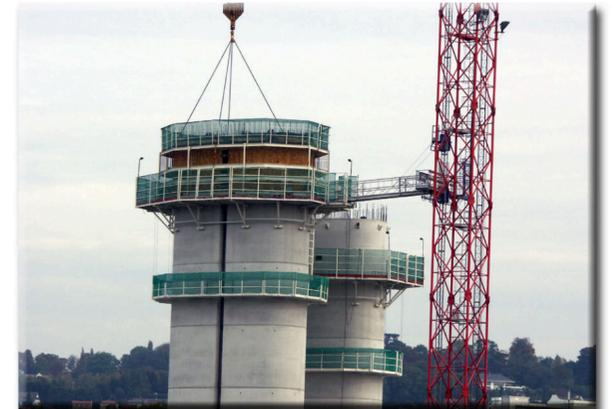
La construction des pylônes nécessite 3 types de passerelle : une passerelle intermédiaire, accrochée au pylône, sur laquelle les coffrages sont posés, une passerelle supérieure, solidaire du coffrage permettant le bétonnage, une passerelle inférieure nécessaire pour les finitions.
