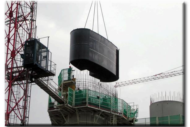
Le coffrage intérieur est positionné à l'intérieur de la cage de ferrailage.
