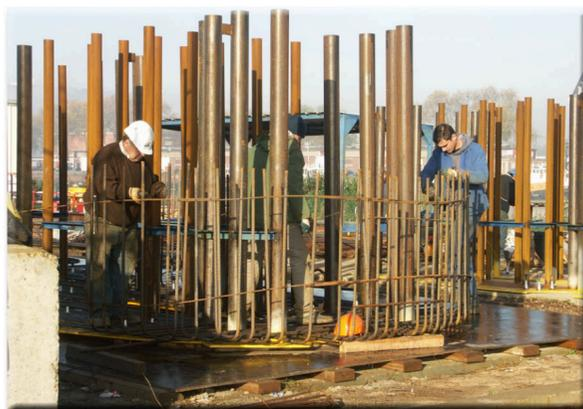
En haut des pylônes, sera bétonnée une dalle de 2 mètres d'épaisseur. Les tubes constituent les futures réservations à travers cette dalle.
