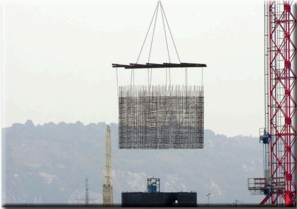
La cage de ferrailage est mise en place à l'aide de la grue à tour.
