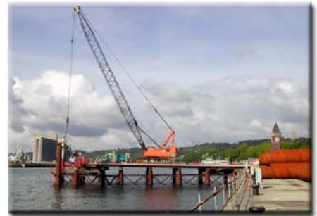
Estacade rive droite en cours de finition. La même opération a été réalisée sur la rive gauche
