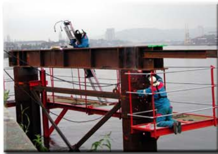
Mise en place de la poutre transversale soudée sur les pieux
