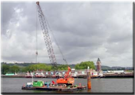
Mise en place des déflecteurs sur les pieux du chenal de navigation
