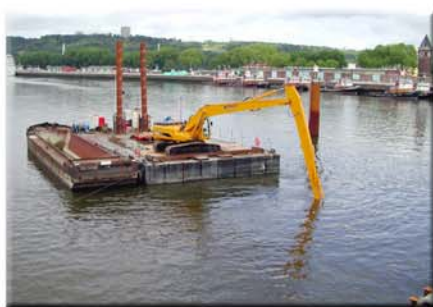
Réglage du fond de la Seine à l'emplacement futur d'un gabion
