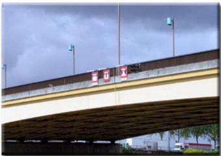
Signalisation fluviale mise en place sur le pont Guillaume le Conquérant (sens aval)
