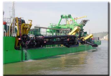
Bras de pompage remonté le long de la drague
