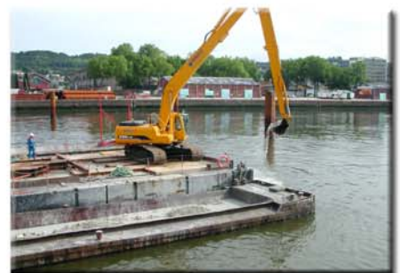
Remplissage de la barge avec les matériaux dragués
