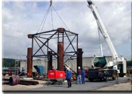
Elément d'estacade préfabriqué au sol sur un gabarit fixe
