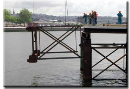
Pose d'un élément d'estacade par simple accrochage à l'élément précédent
