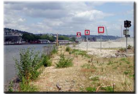
Signalisation fluviale d'approche du chantier (sens amont)
