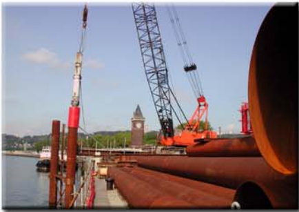
Fonçage des premiers pieux de l'estacade rive droite
