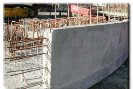
Mention de la destination de l'élément sur l'extérieur du muret (ici, élément coulé le 05/10/04 destiné au gabion Nord amont qui sera placé sur le pieu n° 5 en Seine)
