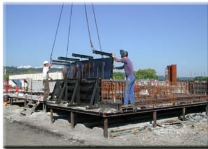
Mise en place des coffrages circulaires du muret extérieur
