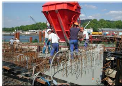
Bétonnage des éléments préfabriqués
