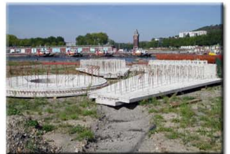
Stockage des éléments à proximité du quai
