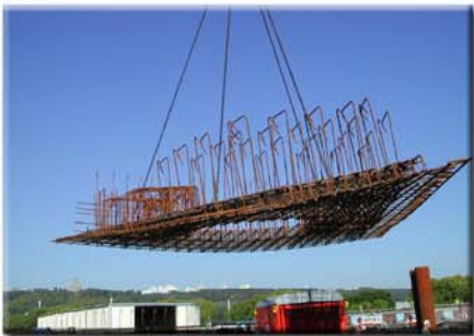
Transport d'une cage d'armature de l'atelier de ferrailage à la plate-forme de coulage
