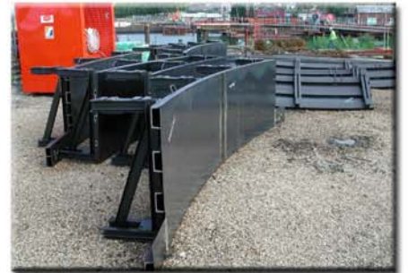
Coffrages en arc de cercle destinés à la réalisation du muret extérieur
