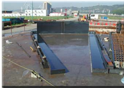
Plate-forme de construction et coffrage des éléments préfabriqués
