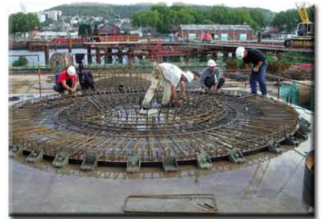
Assemblage du ferrailage de l'anneau circulaire d'un gabion
