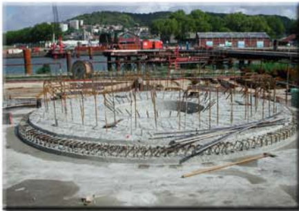
Anneau circulaire bétonné, ménageant une réserve centrale par laquelle passera le pieu métallique
