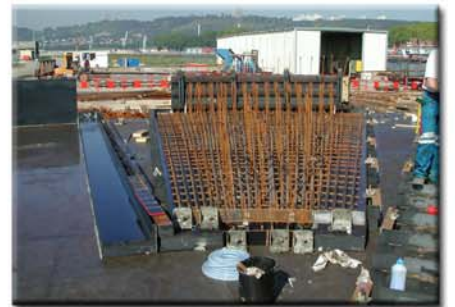
Élément préfabriqué en forme de « pétale » prêt à être bétonné
