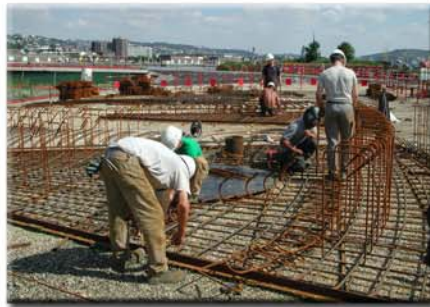
Construction d'un élément porteur, comportant une réserve circulaire au centre de l'armature
