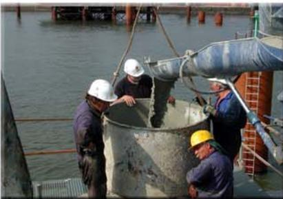
Le tube plongeur est surmonté d'un entonnoir qui recueille directement le béton de la toupie.
