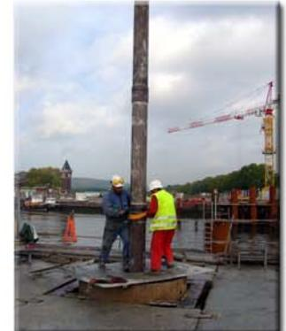
Un tube plongeur est inséré dans le pieu pour la réalisation du bétonnage.
