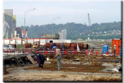
Atelier de préfabrication des éléments de radiers béton.
