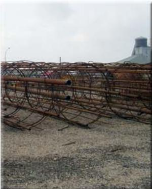
Les cages d'armatures des pieux de fondation sont préfabriquées sur le site.
