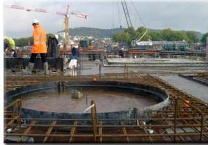
Banc de préfabrication : mise en place des coffrages avant bétonnage.
