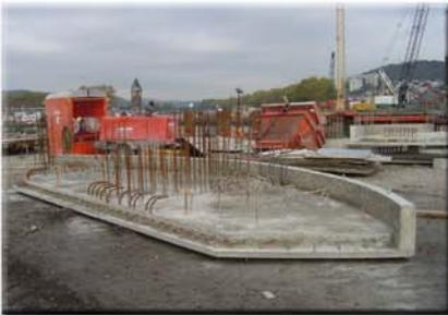
Les éléments du socle, assemblés entre eux, forment le radier de forme ovale des socles de l'ouvrage (35m x 20m).
