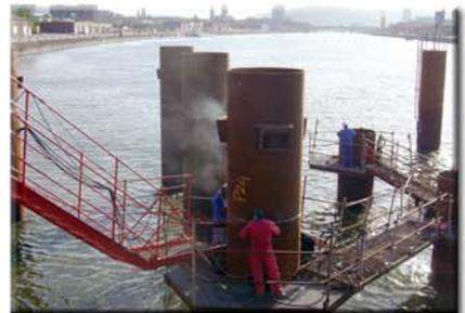
L'élément est positionné à la grue, pointé puis soudé.
