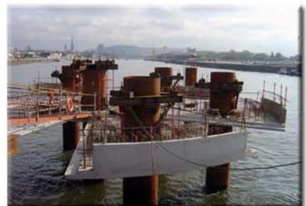
Les éléments préfabriqués des gabions sont constitués de 13 éléments qui, assemblés, représentent le radier circulaire de 20 m de diamètre.
