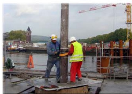
Mise en place des tubes pour le coulage du béton depuis le fond d'un pieu d'un diamètre d'1,80 m
