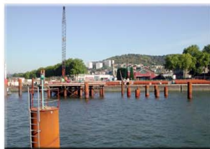
Ensemble des pieux pour les gabions aval et amont réalisés sur la rive droite
