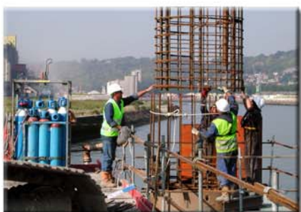
Mise en place des cages d'armature dans un pieu de socle
