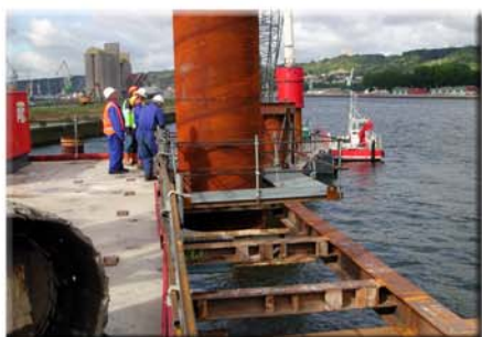
Pose du premier pieu d'un diamètre d'1,80 m pour fondation profonde du socle rive gauche
