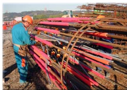
Fabrication des cages d'armature pour les pieux des socles
