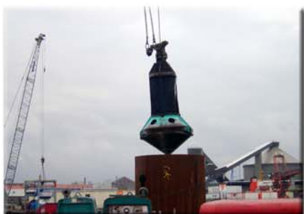
Benne preneuse servant à enlever les matériaux dans les pieux d'un diamètre d'1,80 m
