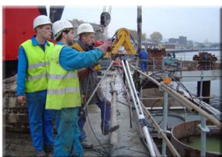
Equipe de contrôle par auscultation sonore du bétonnage des pieux d'un diamètre d'1,80 m en action, qui est effectuée sur l'ensemble des pieux
