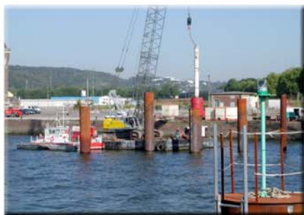
Vue générale de la mise en place des pieux d'un gabion rive droite
