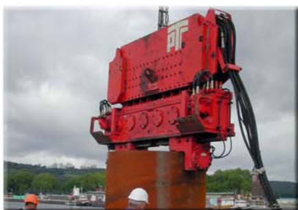
Vibronneur en action sur un pieu d'un diamètre d'1,80 m
