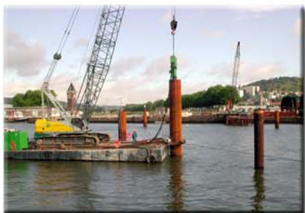
Vibronage du premier pieu d'un gabion rive gauche (pieu central)
