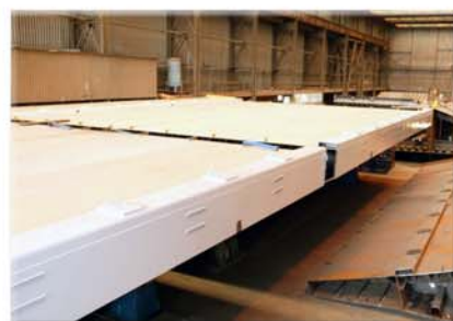
Bord intérieur de la travée levante, sur lequel prendra appui le dispositif de sécurité
