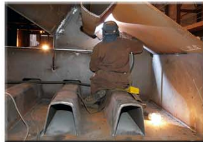
Soudures effectuées, manuellement, à l'intérieur du caisson
