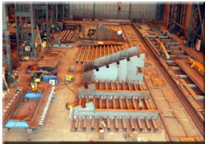
Le caisson prend forme : les augets et les raidisseurs transversaux sont mis en place ainsi que les premiers diaphragmes
