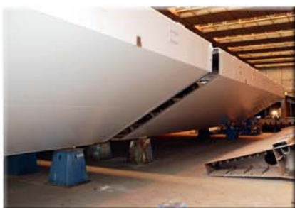
Deux éléments de travée levante sont prêts à être raccordés
