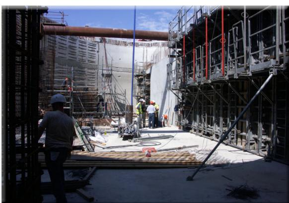
Les coffrages sont montés pour effectuer la réalisation des voiles intérieurs.
