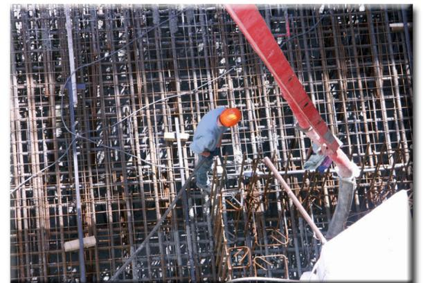
Le bétonnage peut commencer : deux ateliers complets comprenant toupies et pompes à béton permettront de mettre la totalité du volume sans interruption.
