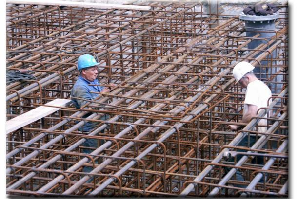
La pose des cages d'armatures destinées à recevoir le radier final d'une épaisseur de 3 m, est effectuée par les compagnons.
