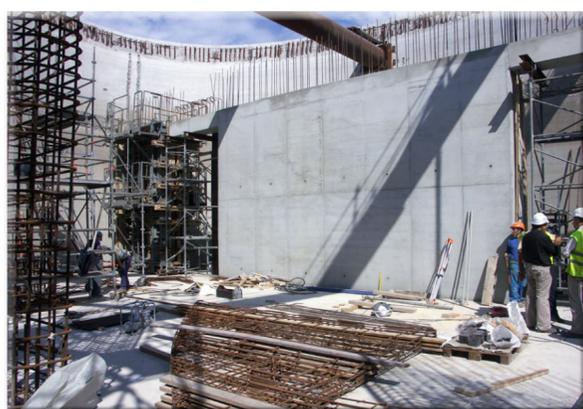
Les premiers voiles sont décoffrés. Ces murs (voiles) sont les cloisons des locaux techniques destinés à recevoir les mécanismes de levage.
