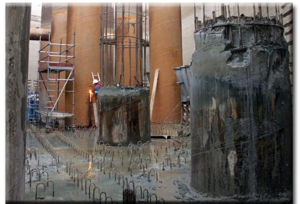
Une fois l'étanchéité terminée, les socles sont vidés de leur eau par des pompes d'un débit de 300 m<sup>3</sup>/heure. Les têtes des pieux Ø1800 sont découpées au chalumeau et enlevées par grutage.
