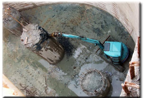
A hauteur du premier radier, le recépage des têtes de pieux bétonnés est réalisé à l'aide d'une mini-pelleteuse descendue au fond et équipée d'une pointrolle vibrante.
