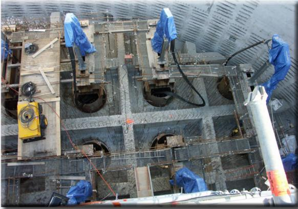
Vue de l'intérieur d'un socle montrant les tubes métalliques et les murs raidisseurs, entre lesquels le béton immergé va être coulé.
