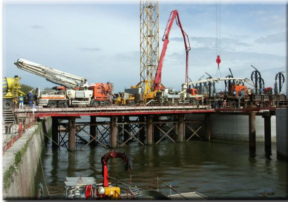
Vue d'ensemble du matériel (toupies + pompes à béton), nécessaire à l'acheminement du béton sur le fond de socle. Le béton immergé permettra l'étanchéité du socle par rapport à la Seine et la fixation du socle sur les tubes métalliques.
