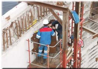
Mise en place des platines métalliques qui recevront les butons (tubes en acier permettant aux murs en béton du socle de résister à la poussée de l'eau)
