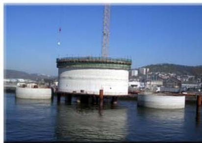
Vue du chantier rive droite : les deux gabions sont posés en fond de Seine, le socle, en fin de bétonnage
