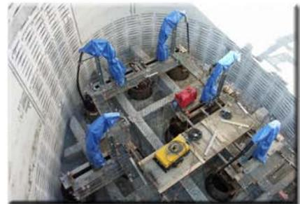
Pendant tout le bétonnage du mur périphérique, les vérins et les câbles sont protégés par des bâches
