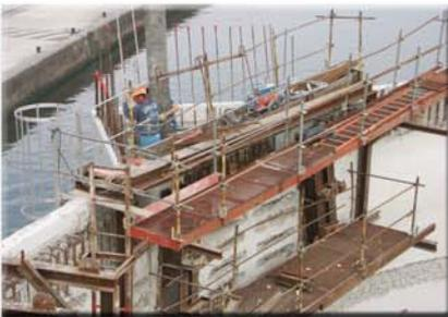
Bétonnage de l'intérieur de l'élément préfabriqué de la pile
