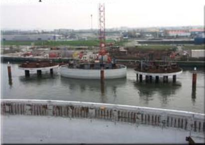
Vue du chantier rive gauche : le socle est placé en fond de Seine, entre les deux gabions en cours de construction
