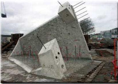
Élément de base d'un élément de pile préfabriqué, avant sa mise en place
