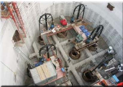
Les murs raidisseurs de 1,10 m de hauteur sont construits. Les platines pour butons sont en place sur le mur
