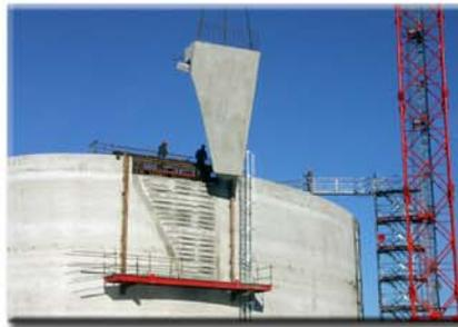
L'élément de base de la pile fixe est hissé, afin d'être placé sur l'empreinte visible du mur
