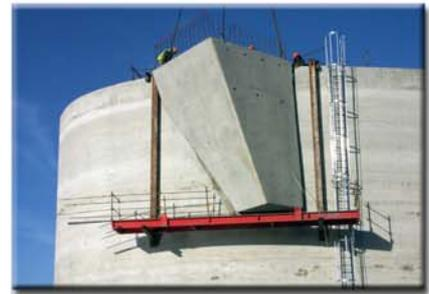
Fixation de l'élément préfabriqué, par sa partie supérieure, au sommet du mur. Sur cet élément, reposera le tablier du pont
