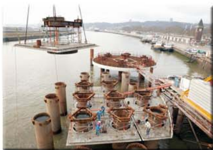
Ces éléments sont ensuite montés avec leur suspentes provisoires, sur chaque pieu de fondation
