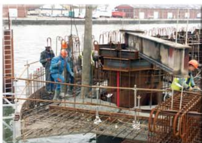
Coulage de la première épaisseur de 30 cm formant la liaison de tous les éléments préfabriqués
