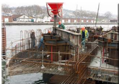
Coulage de la première épaisseur de 30 cm formant la liaison de tous les éléments préfabriqués
