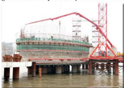
Le bétonnage à une distance aussi grande est possible, grâce au bras articulé de la pompe à béton
