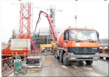
La toupille et la pompe à béton sont en action de bétonnage
