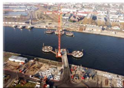
Vue générale du chantier. En bas de la photo, la totalité des éléments préfabriqués du socle est visible
