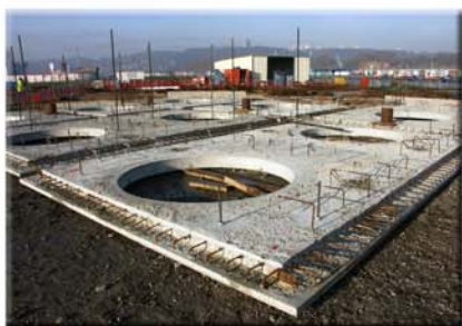
Les éléments sont préfabriqués, sur place, de la même manière que pour les gabions
