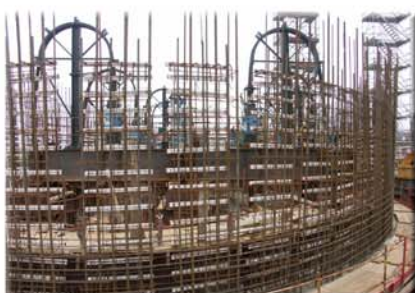
Les premières cages de ferrailage verticales du socle sont disposées sur le ponton du radier. L'ensemble est suspendu à des câbles maintenus aux tubes de fondation, par l'intermédiaire de vérins. Le coffrage glissant est mis en place. Un système de vérins le fera monter graduellement tout au long du bétonnage
