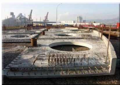
Les éléments sont préfabriqués, sur place, de la même manière que pour les gabions
