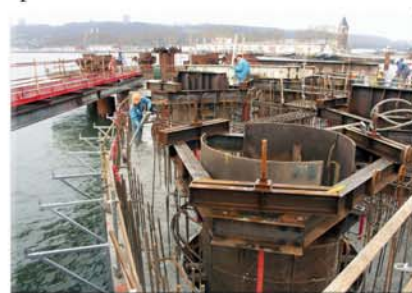
Coulage de la première épaisseur de 30 cm formant la liaison de tous les éléments préfabriqués
