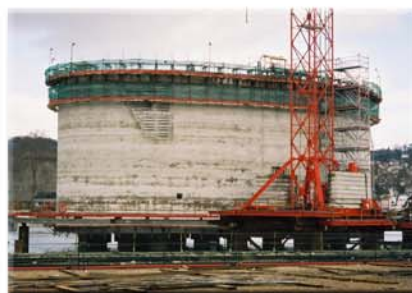
Le mur périphérique du socle est maintenant achevé
