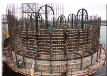
Les premières cages de ferrailage verticales du socle sont disposées sur le ponton du radier. L'ensemble est suspendu à des câbles maintenus aux tubes de fondation, par l'intermédiaire de vérins. Le coffrage glissant est mis en place. Un système de vérins le fera monter graduellement tout au long du bétonnage
