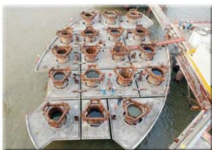
Ces éléments sont ensuite montés avec leur suspentes provisoires, sur chaque pieu de fondation
