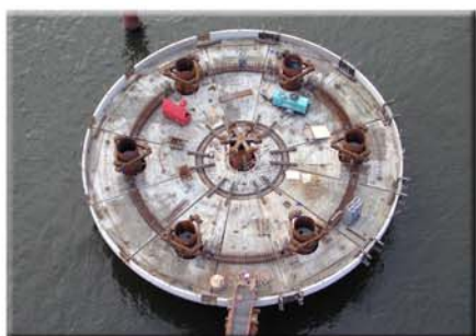
Liaison de tous les éléments par clavage vers l'anneau central et raidisseur circulaire avant bétonnage effectuée
