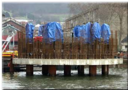
Prise en charge du radier par les vérins, bûchés pendant la construction du mur périphérique (voile) d'1 m d'épaisseur
