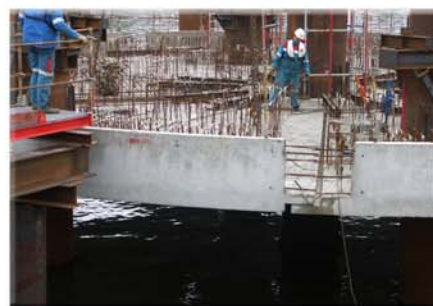
Élément en position finale (jonctions du muret extérieur à réaliser)
