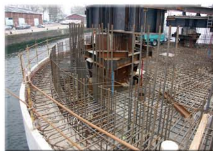
Placement d'une poutre destinée à recevoir les couples de vérins sur chaque tube métallique
