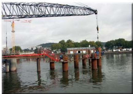
Approvisionnement des réhausses destinées à recevoir les triangles de suspenste provisoire des éléments préfabriqués
