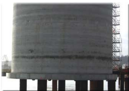
Lancement de l'opération par dévérinage du gabion achevé
