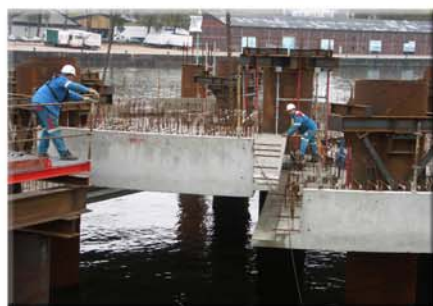
Mise en place du dernier élément d'un gabion (à droite un triangle de suspenste provisoire)
