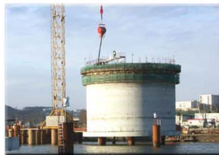
Bétonnage du mur périphérique (voile) par coffrage glissant en voie d'achèvement
