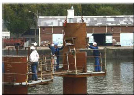
Mise en place des réhausses
