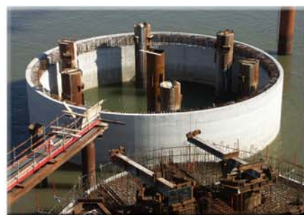
Premier gabion posé sur le fond de la Seine préalablement nivelé par des plongeurs
