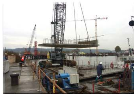
Acheminement des éléments préfabriqués par ponton flottant
