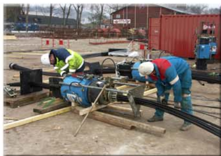
Mise en place des torons (éléments de câble) dans chaque vérin
