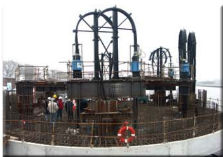
Mise en place des guides de torons (câbles) et vérins sur tous les tubes métalliques
