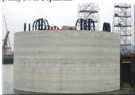
Descente du gabion par courses successives de 18 cm (durée de l'opération : entre 8 et 10 heures)
