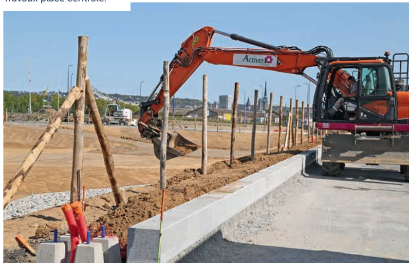
Travaux place centrale.
