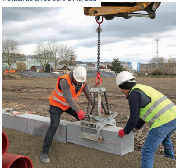
Travaux de la rue Berthe Morisot.
