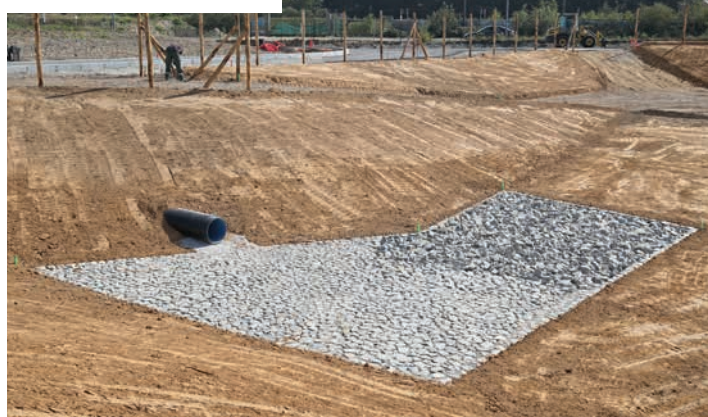
Bassin de la place centrale en cours de réalisation
