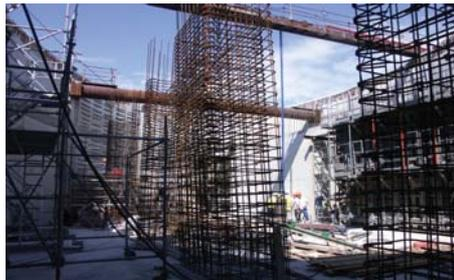
Les cages d'armatures fabriquées au sol sont posées. Elles forment l'ossature des voiles.
