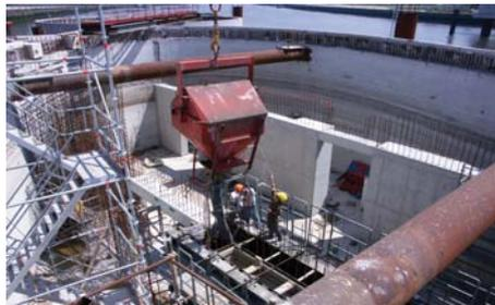
L'opération de bétonnage s'effectue par grutage à l'aide d'une benne de 2 m<sup>3</sup>.
