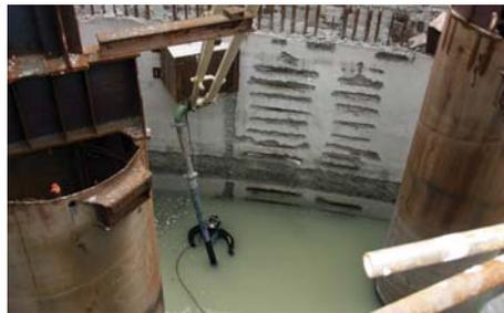
Le béton est injecté par une pompe sur une épaisseur de 1,50 m.
