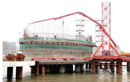
Bétonnage du mur périphérique
