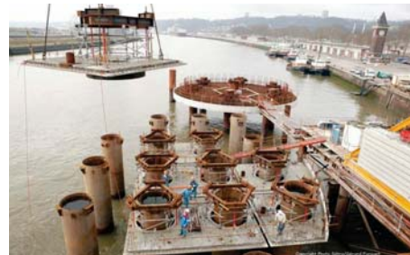
Eléments préfabriqués montés sur les pieux de fondation.
