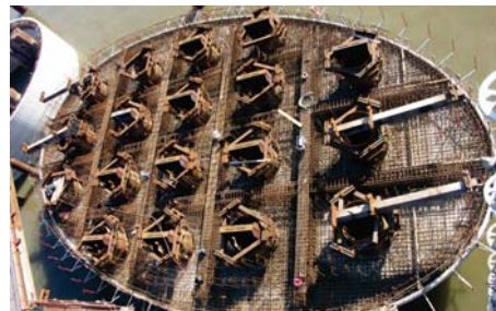
Les dimensions du radier du socle de forme ovale sont de 35 m par 20 m
