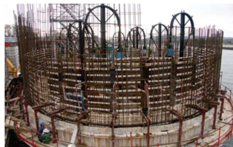
Mise en place des cages de ferrailage verticales
