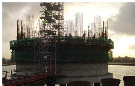
*Pour le bétonnage du mur périphérique, le chantier fonctionne 24h sur 24.*
