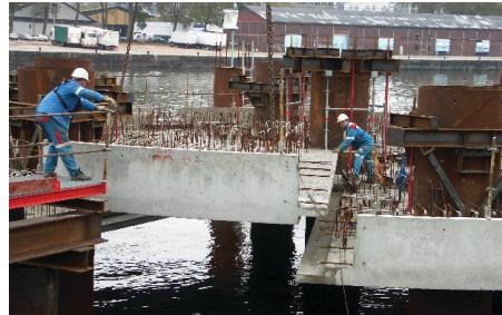
*Mise en place d'un élément en "pétales", sur le gabion amont de la rive droite.*
