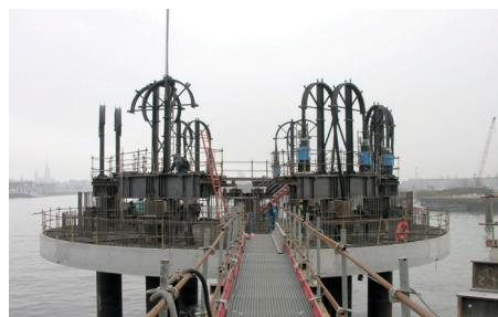
*Système de dévérinage (descente) installé sur un gabion*
