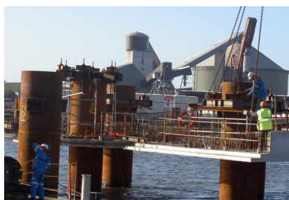
L'élément circulaire et un élément en forme de "pétale" sont en place sur le gabion amont de la rive droite
