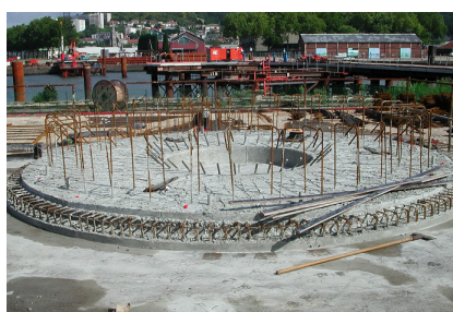
Élément circulaire d'un gabion en préfabrication
