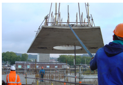
Élément en forme de "pétale" d'un gabion en préfabrication
