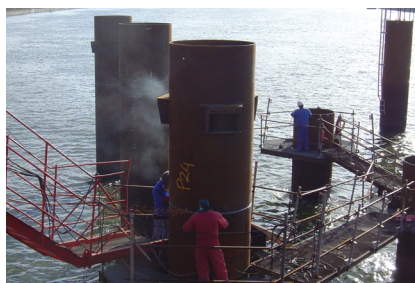
Mise à la côte des pieux de fondation du gabion amont de la rive droite
