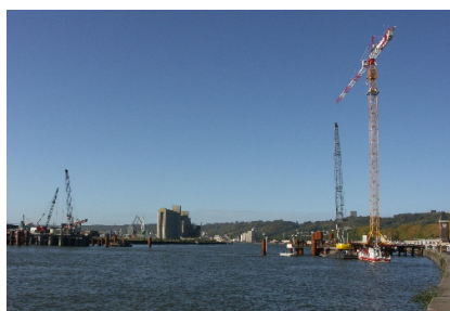
Vue générale du chantier depuis la rive droite
