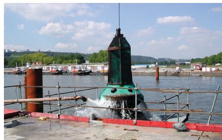
*Eracuation du sol déstructuré en fond de tube à l'aide d'une benne prenante*
