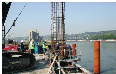
*Mise en place des cages d'armature circulaire*
