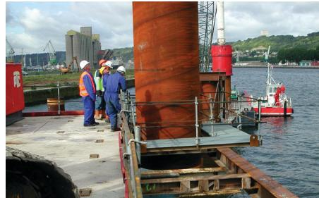
*Mise en place des tubes de pieux du socle de la rive gauche*
