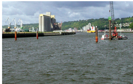
Mise en place de la signalisation fluviale
