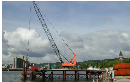
Estacade rive droite
