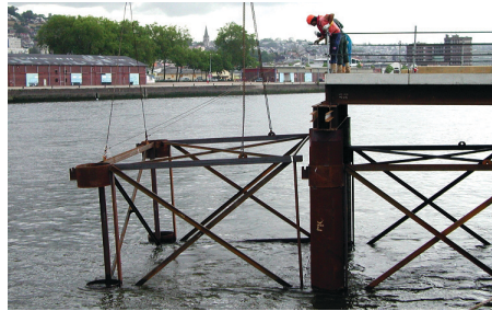
Mise en place des contreventements* pour le montage de l'estacade
