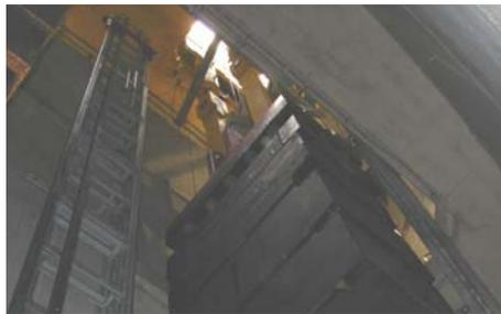
Intérieur du pylône : rails de guidage, contre poids, câbles...
