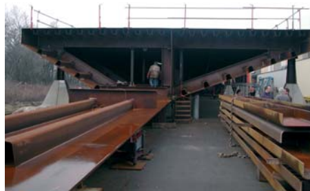
Vue d'ensemble du tablier en cours d'assemblage, dans l'usine.
