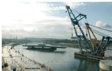
Une manoeuvre en cours.
