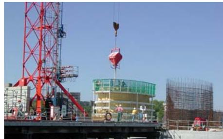
Mise en oeuvre du béton au moyen d'une benne de 2m<sup>3</sup>.
