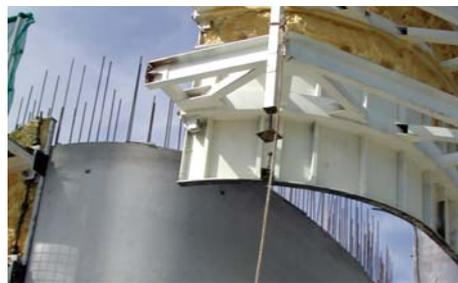
Dépose d'un demi-élément de coffrage extérieur.
