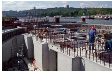
Réglage des panneaux de coffrage.
