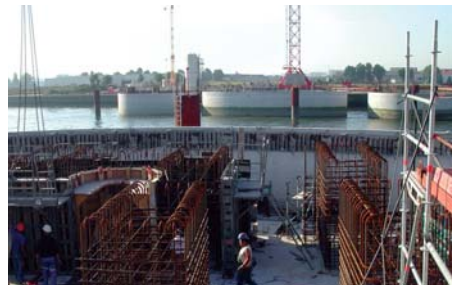
Préparation des "murs intérieurs". Mise en place du ferrailage.
