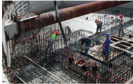
Exécution de la dalle intermédiaire.
