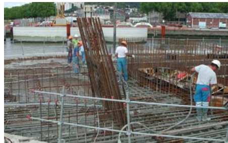
L'opération de bétonnage de la dalle supérieure requiert 320 m 3 de béton.
